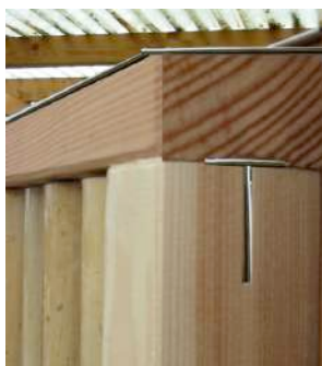
Aluminium T-Eisen eingefräst & Edelstahlabdeckung
