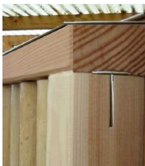
Aluminium T-Eisen eingefräst & Edelstahlabdeckung
