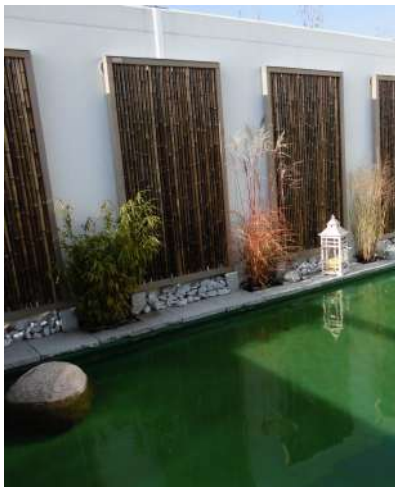
Bambus „Moso dunkel“ mit Rahmen aus österreichischer Gebirglärche behandelte mit HS Lärchengrau Vergrauungsöl mit Edelstahlabdeckung
