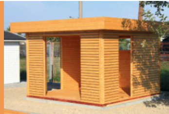
Dach- und Wandschalung
