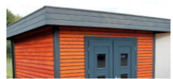
Flachdach (mit Dachüberstand)
