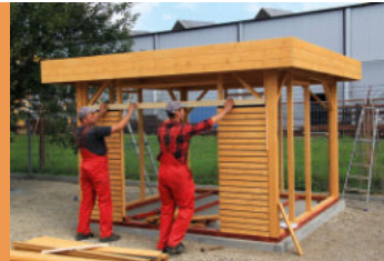
Anbringen der Rhombusschalung
