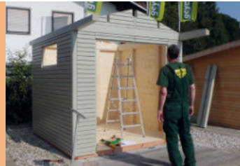
Einsetzen der fertig montierten Wand- und Giebelelemente
