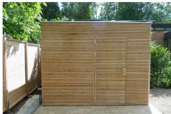
Kreatives Gartenhaus KUBUS mit innenliegendem Pultdach. Einzeltüre. Verkleidung in LIGNUM auf Viola aus Latten 26x45 (Sichtseite 26 mm) auf Verbundplatte in V2A verschraubt. Winddicht. Stahlblechrahmen 3-seitig Innen & Oben Ugitop
