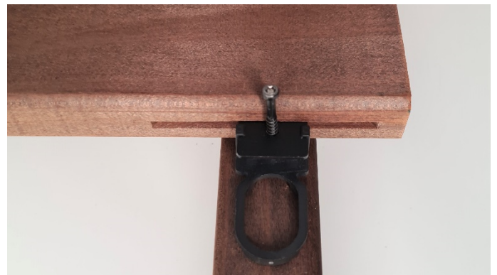
Bild 42. Der RASK-Clip muss mittig in der Ausfräsung positioniert werden.
